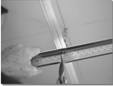
Instale os perfis T secundários do perímetro
