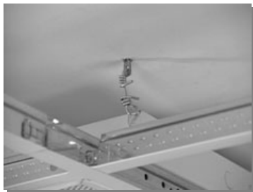
A suspensão pode requerer suspensores adicionais para suportar o peso dos artefatos de iluminação
