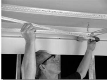
Coloque em esquadro a suspensão medindo através da diagonal da abertura da mesma
